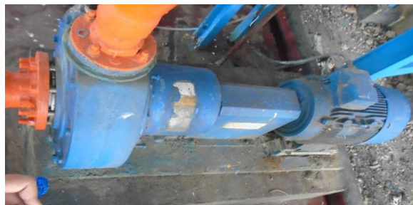
Gambar 3. Pompa Sentrifugal di PT. X
